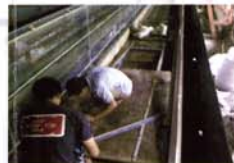
Instalasi Struktur Model
