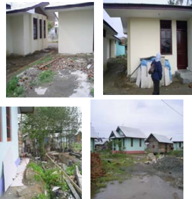
RUANG ANTAR RUMAH SEMPIT & TIDAK ADA SALURAN
